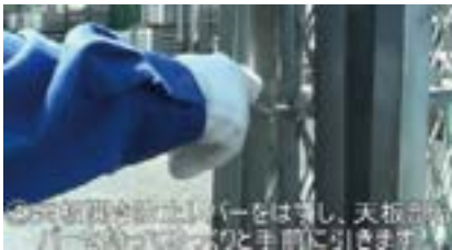
④ 天板開き防止バーを引くときは押し、天板開き防止バーを引くときは引くように注意してください 確認よいか... ヨシ! 天板開き防止バー解除良いか
