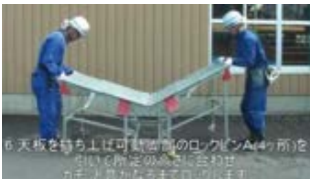
⑦ 天板を持ち上げ可動脚部のロックピンA(4ヶ所)を引いて所定の高さに合わせてロックします 確認よいか... ヨシ! 作業高さ確認良いか
