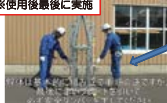
確認よいか... 昇降用梯子フック穴引っ掛け良いか 昇降用梯子固定用金具本体と連結良いか
