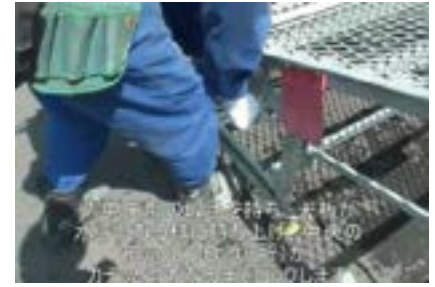
⑨ 天板を持ち上げ可動脚部のロックピンA(4ヶ所)を引いて所定の高さに合わせてロックします 確認よいか... ヨシ! 中央ロックピン4ヶ所固定良いか
