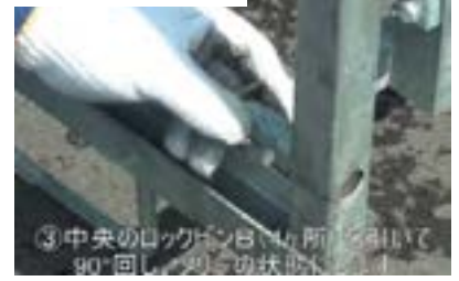
③ 中央のロックピン(4ヶ所)を引いて90°回し、フリーの状態にします 確認よいか... ヨシ! 中央ロックピン4ヶ所フリー良いか
