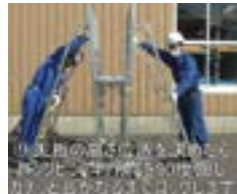
確認よいか... ロックピン固定4ヶ所固定音確認良いか
