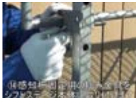
確認よいか... 感知柵大固定用金具本体と連結良いか
