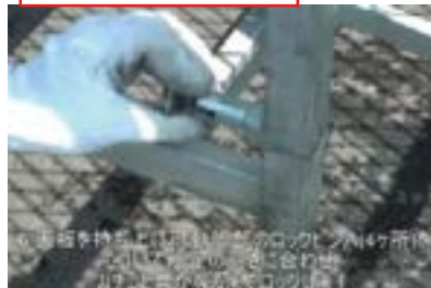
⑧ 天板を持ち上げ可動脚部のロックピンA(4ヶ所)を引いて所定の高さに合わせてロックします 確認よいか... ヨシ! 脚部ロックピン4ヶ所固定良いか
