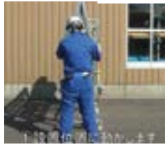
確認よいか... 設置場所の足元良いか
