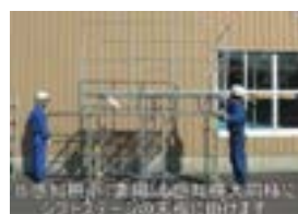
確認よいか... 感知柵小フック穴引っ掛け良いか 感知柵小フレ止めフック固定良いか 感知柵小固定用金具本体と連結良いか
