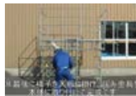
確認よいか... 昇降用梯子フック穴引っ掛け良いか 昇降用梯子固定用金具本体と連結良いか
