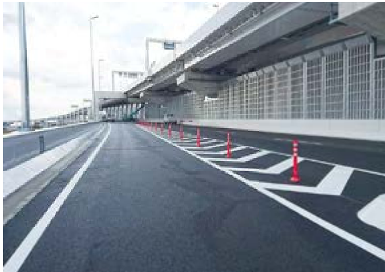
首都高速道路 横浜環状北線
