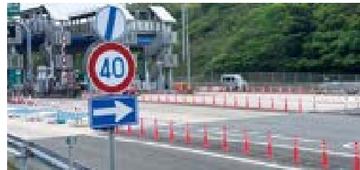
瀬戸内しまなみ海道 向島料金所 逆走対策
