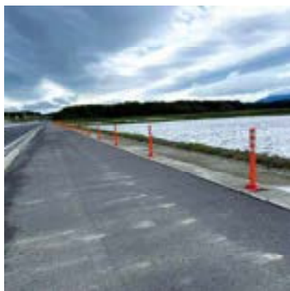
三重県 国道 23 号側道
