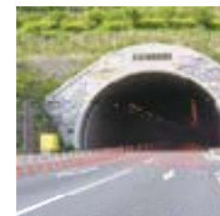
長野県 湖北トンネル
