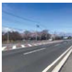
茨城県 国道 245 号
