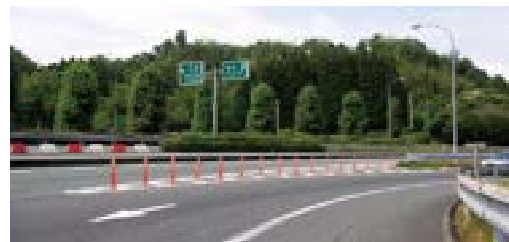
九州自動車道 松橋 IC 入口 逆走対策
