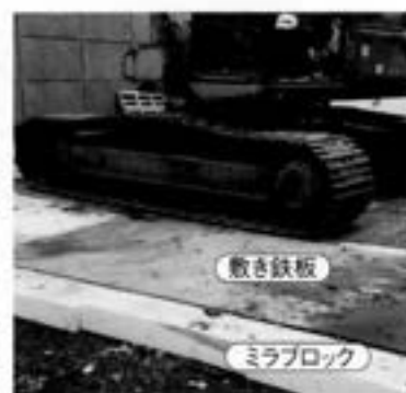
工事振動対策例
