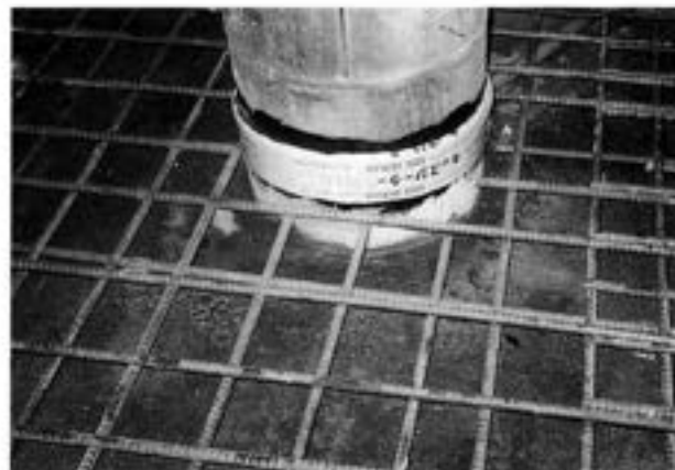
▲土間コンと鉄柱のエキステンションジョイントに
